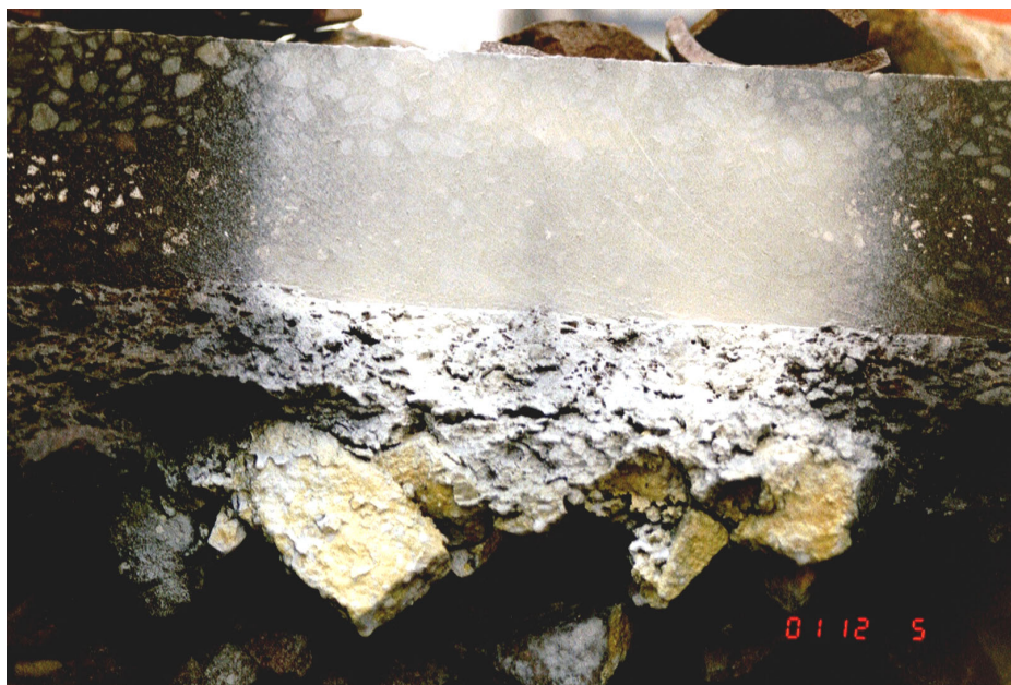
Bild 1.1-1 Makadam indränkt med stenkolstjära under flera lager asfalt
